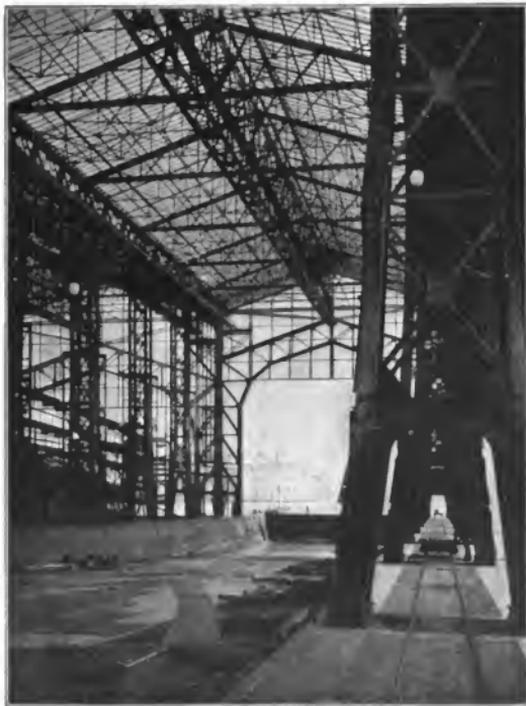
Fig. 4. Inneres eines Hellinges mit Blick auf die Hellingbahn.
